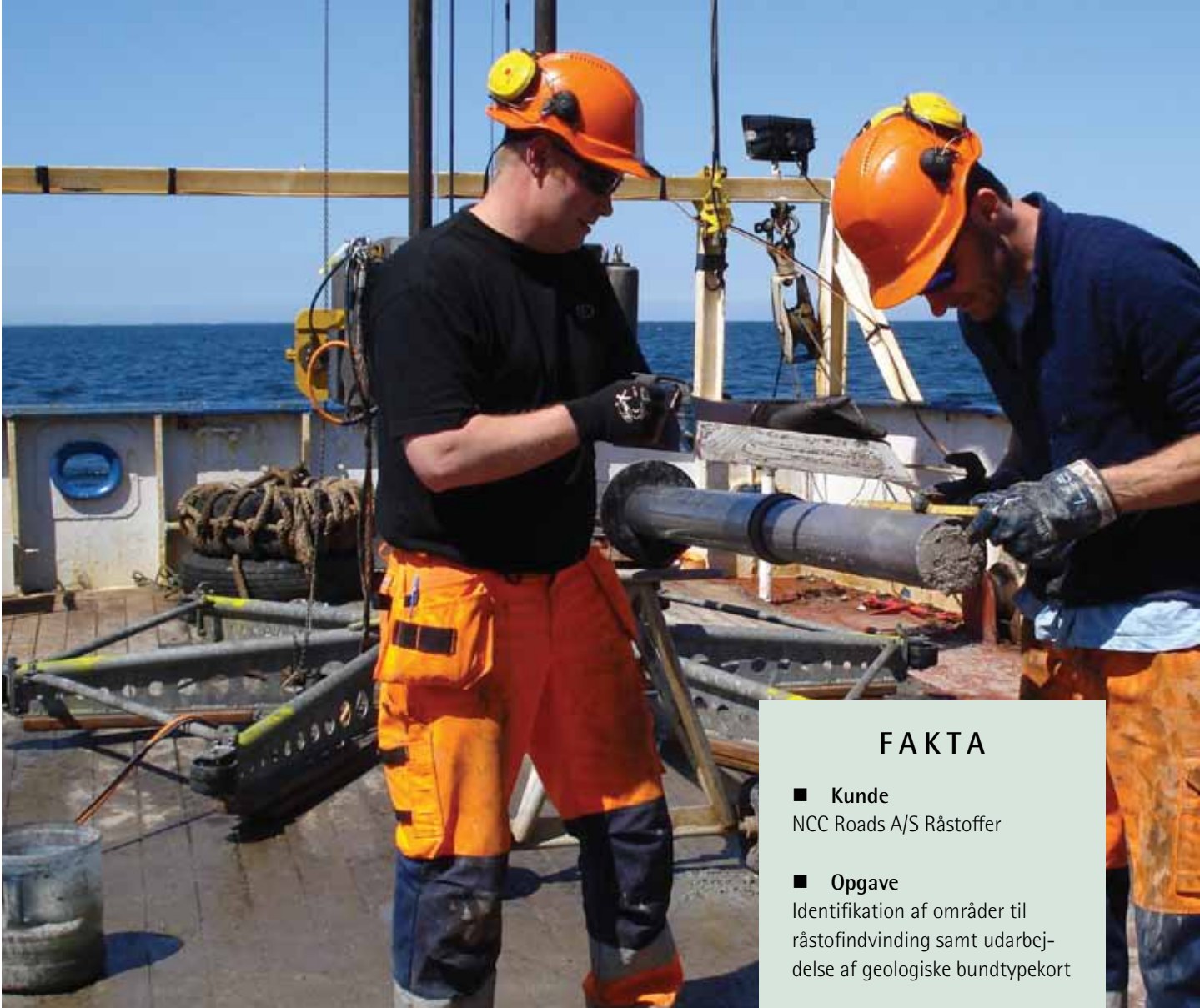
Prøvetagning med vibrocore.
