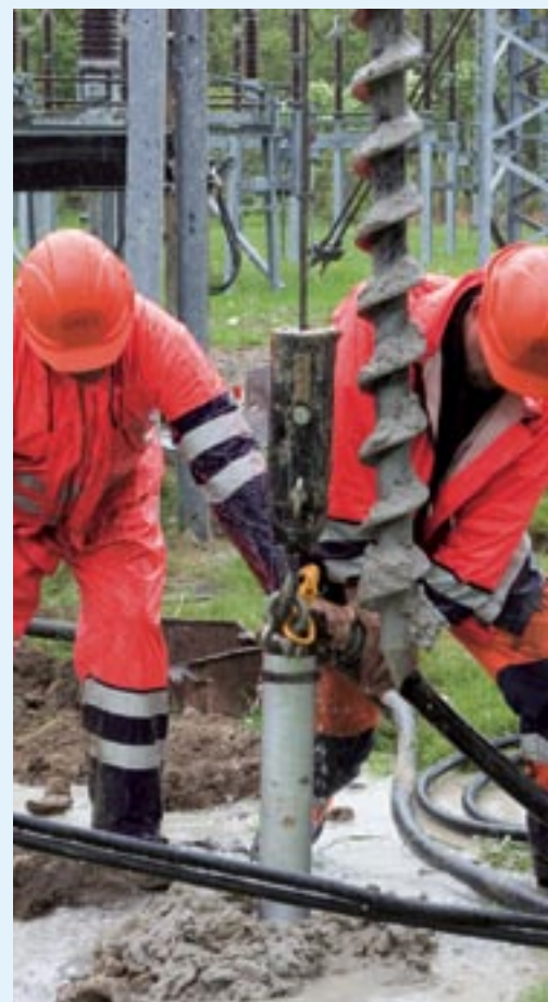
Etablering af sugespids i byggegrube.
