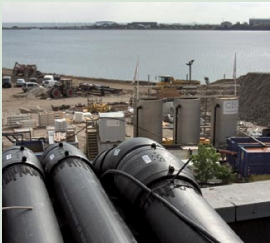
Grundvandssænkningen ved Tuborg Havn.
